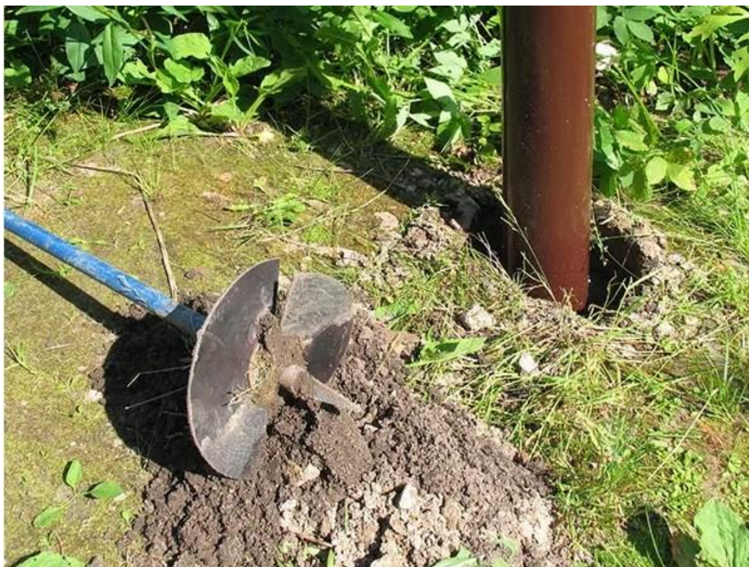
Установка опорного столба с помощью ямобура
